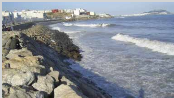
Protection de la corniche de la ville de Fnideq
