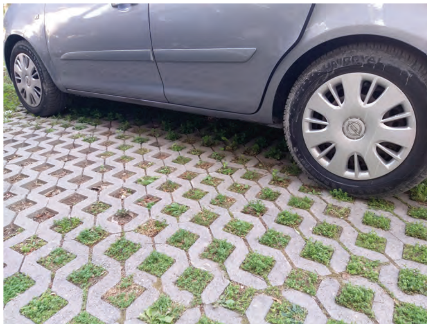
Slika 62. Primjer parkirališta s većom propusnosti materijala (fotografija: Ivan Sekovski)
